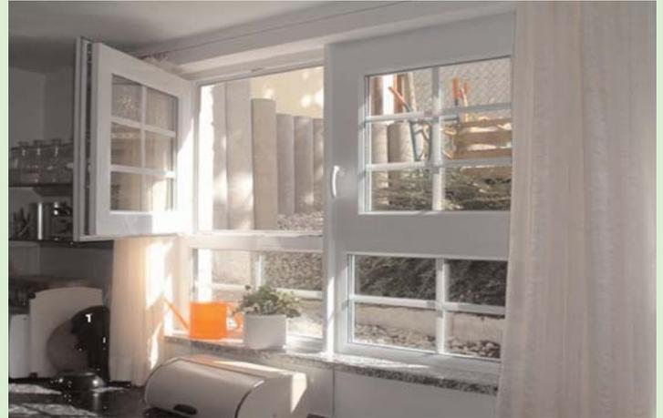
*Drehkippfenster Nautilus Hybrid: öffnet nach innen, unten fix, ideal für Grundwasser*
