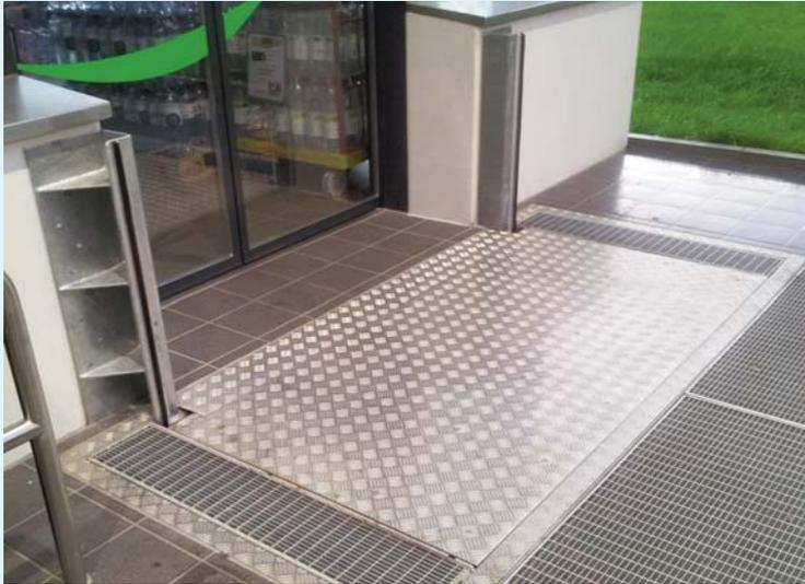
Die Auftriebskraft der einlaufenden Flüssigkeit hebt einen Schwimmer, das Klappschott wird von Gasfedern hochgeklappt und gegen die Dichtungen gedrückt.
